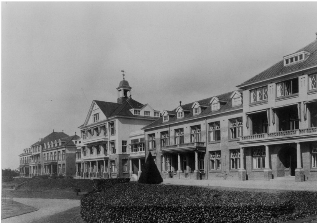
Hoofdgebouw Dekkerswald na de verbouwing van 1929.
